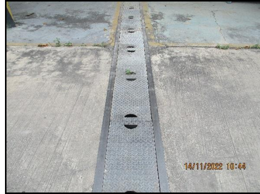
ภาพที่ 2.24 รางระบายน้ำฝนรอบพื้นที่โรงงาน
