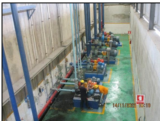
ภาพที่ 2.73 เครื่องสูบน้ำดับเพลิง บริเวณประปา
