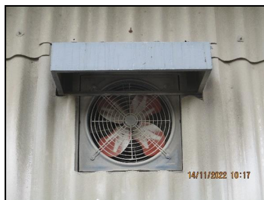
ภาพที่ 2.49 ระบบระบายอากาศเฉพาะที่
