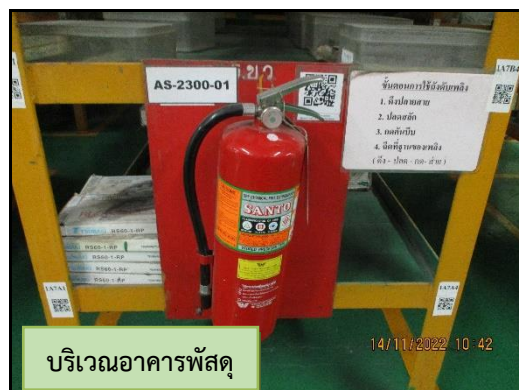
ภาพที่ 2.68 ถึงดับเพลิงมือถือภายในบริเวณต่างๆรอบพื้นที่โครงการ
