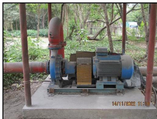
ภาพที่ 2.74 เครื่องสูบน้ำดับเพลิง บริเวณบดซีเมนต์เขาวง
