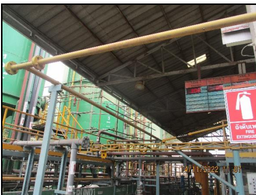
ภาพที่ 2.66 หัวฉีด และระบบหัวกระจายน้ำ-โฟม บริเวณถังเก็บของเสียที่เป็นของเหลว
