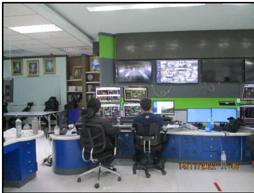
ภาพที่ 2.1 กล้องวงจรปิดเพื่อสังเกตความเข้มข้นของฝุ่นจาก ปลายปล่องหม้อเผาภายในห้องควบคุมการผลิต
