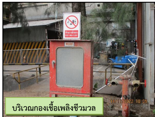
ภาพที่ 2.81 ท่อรับน้ำและสายจ่ายน้ำดับเพลิงภายในโครงการ
