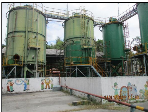
ภาพที่ 2.61 สภาพบริเวณถังกักเก็บของเสียที่เป็นของเหลวและ Bund Wall รอบถังกักเก็บ
