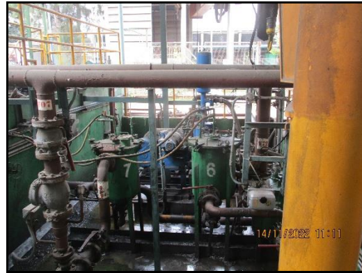
ภาพที่ 2.28 ปัมป์สูบน้ำบริเวณถังเก็บของเสีย
