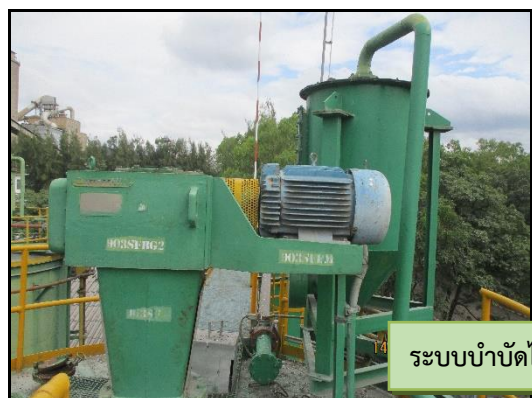
ภาพที่ 2.17 ถังเก็บของเสียที่เป็นของเหลวและระบบบำบัดไอสารอินทรีย์
