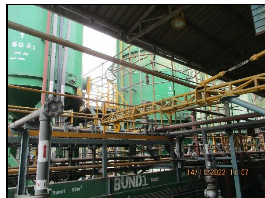
ภาพที่ 2.61 สภาพบริเวณถังกักเก็บของเสียที่เป็นของเหลวและ Bund Wall รอบถังกักเก็บ
