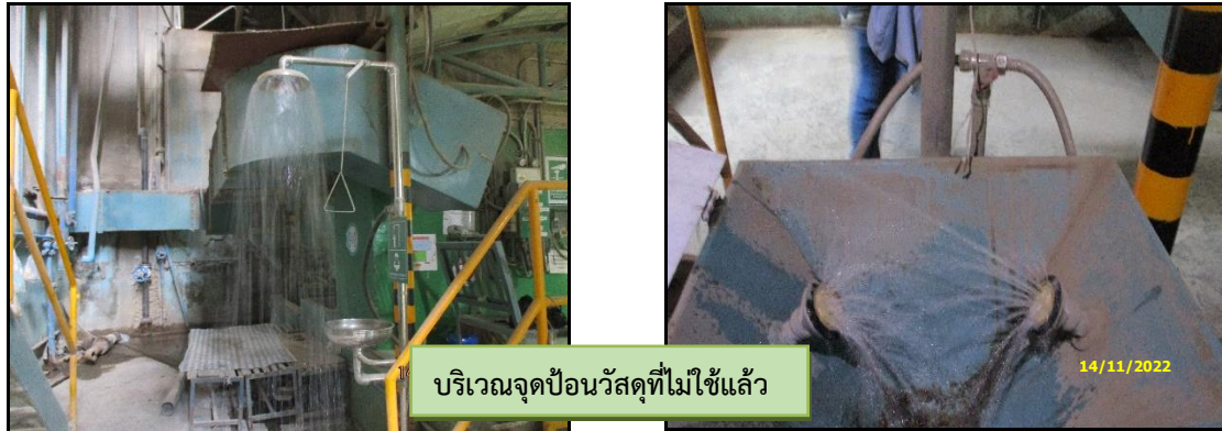
ภาพที่ 2.83 (ต่อ) จุดชำระล้างในกรณีเกิดเหตุฉุกเฉิน
