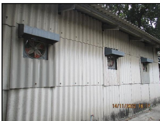
ภาพที่ 2.49 ระบบระบายอากาศเฉพาะที่
