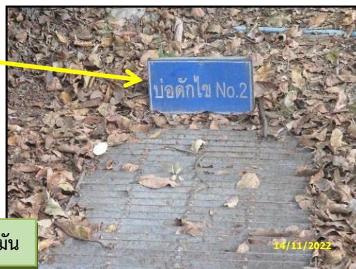
ภาพที่ 2.27 ตะแกรงดักขยะและบ่อดักไขมันบริเวณถังเก็บของเสียที่เป็นของเหลว
