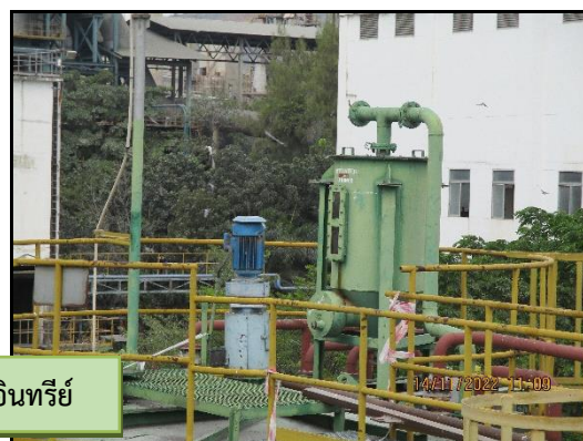
ภาพที่ 2.17 ถังเก็บของเสียที่เป็นของเหลวและระบบบำบัดไอสารอินทรีย์
