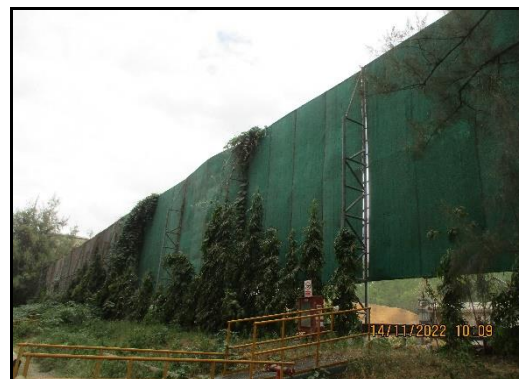
ภาพที่ 2.79 ระบบป้องกันฝุ่นเชื้อเพลิงชีวมวล
