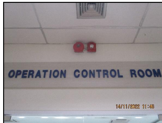
ภาพที่ 2.82 (ต่อ) สัญญาณเตือนภัย และเครื่องตรวจจับควัน (Smoke Detector) บริเวณอาคาร CCR
