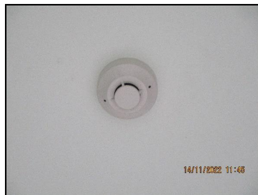
ภาพที่ 2.82 สัญญาณเตือนภัย และเครื่องตรวจจับควัน (Smoke Detector) บริเวณอาคาร CCR
