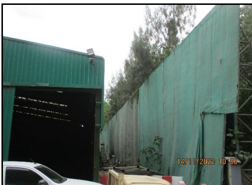
ภาพที่ 2.79 ระบบป้องกันฝุ่นเชื้อเพลิงชีวมวล
