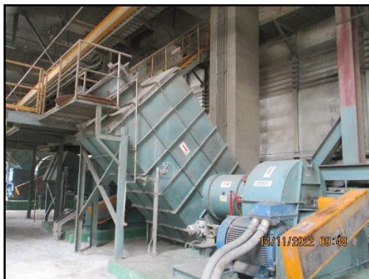
ภาพที่ 2.11 IKN Clinker Cooler
