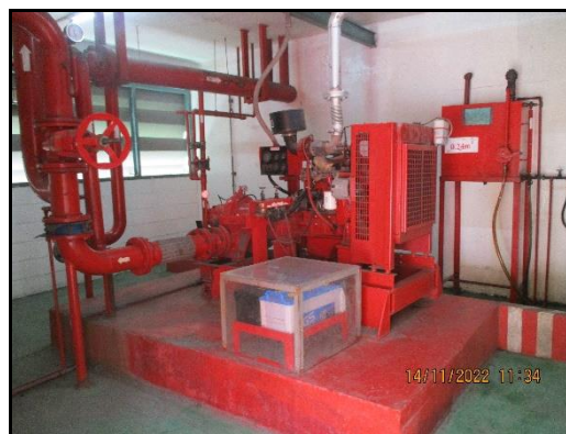
ภาพที่ 2.72 เครื่องสูบน้ำดับเพลิง บริเวณโรงผลิตถุงกระดาษ
